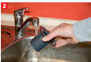
Den Geruchsverschluss unter Wasser säubern
